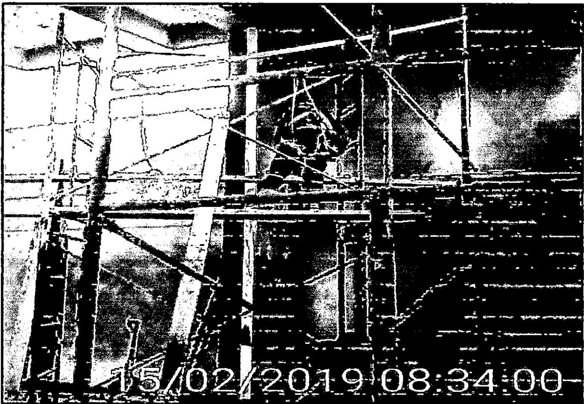
Imagen N°12: A la vista de la imagen se aprecia a los trabajadores realizando trabajos de tarrageo en la zona de frío usando los andamios correctamente normalizados y con sus 'línea de vida y sus arnés.
