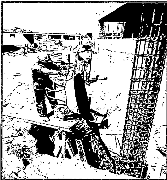
Vaciado de zapata, pórtico de ingreso principal.
