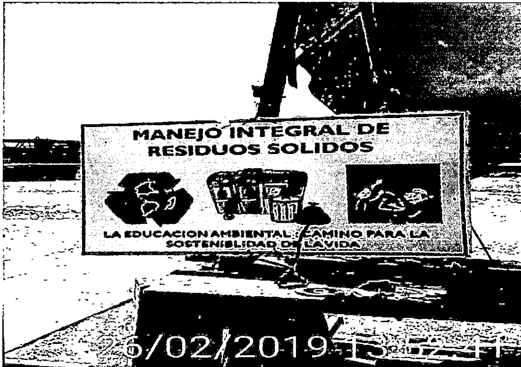
Imagen N°18: A la vista de la imagen se aprecia que la obra esta rotulado con letreros para motivar el cuidado del medio ambiente a los trabajadores-
