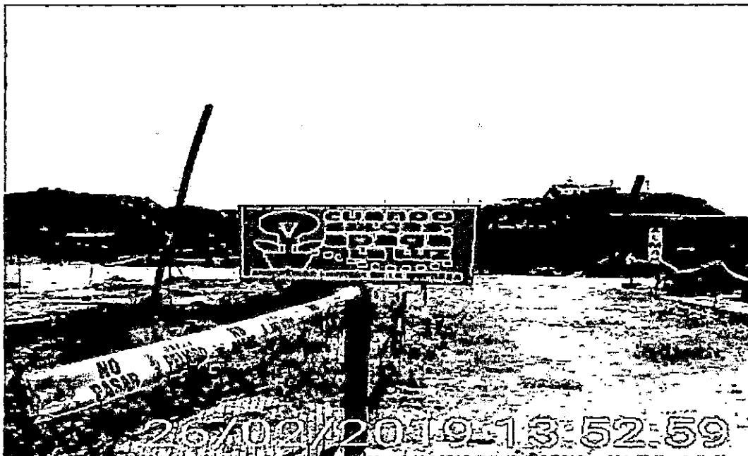
Imagen N°19: A la vista de la imagen se aprecia que la obra esta rotulado con letreros para motivar el cuidado del medio ambiente a los trabajadores.
