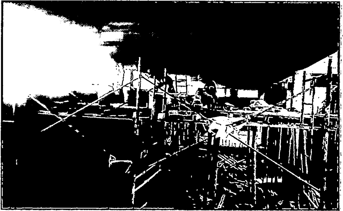
Tarrajeo de Cielo raso y vigas en Frio 1er Nivel en todos sus ambientes respectivos con las especificaciones correspondientes.
